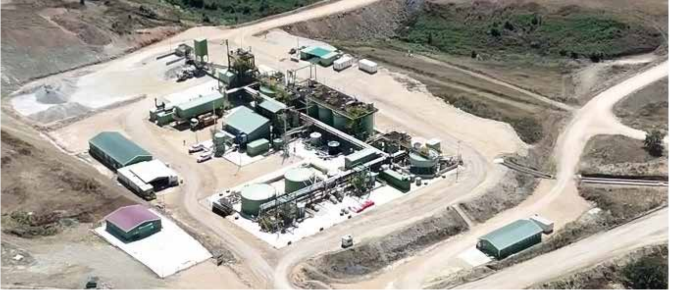
Sögüt Altın Madeni Faz-1 Tesis
